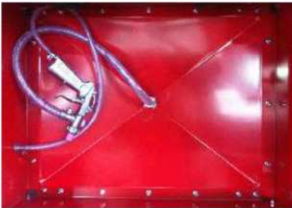
5.ábra: Vezetékek szerelése a tölcsernél
